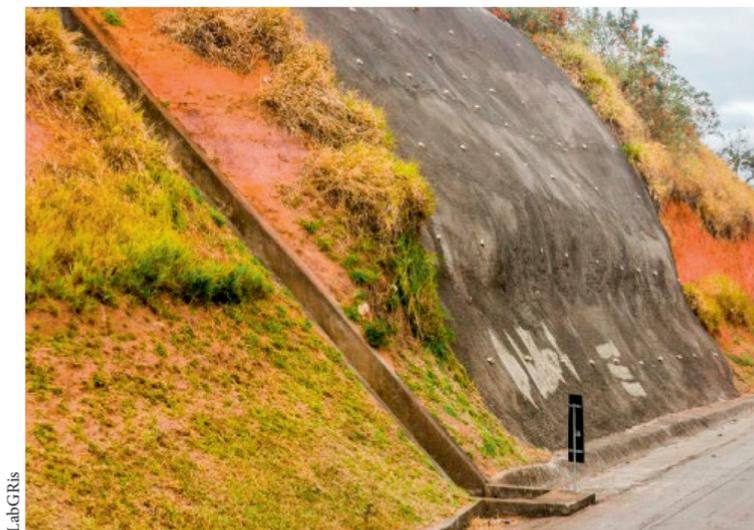
*Figura 2. Impermeabilização superficial de talude com concreto projetado.*
