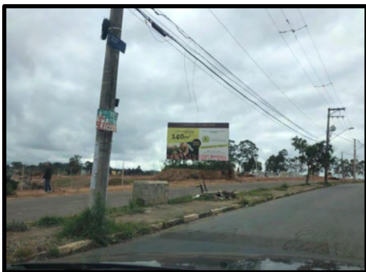
Foto n.º 11 - Detalhe de loteamento sendo implantado próximo à rodovia.
