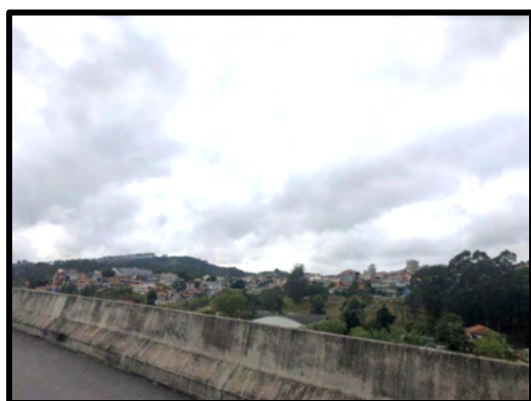
Foto n.º 02 - Outra vista parcial da rodovia e loteamento.
