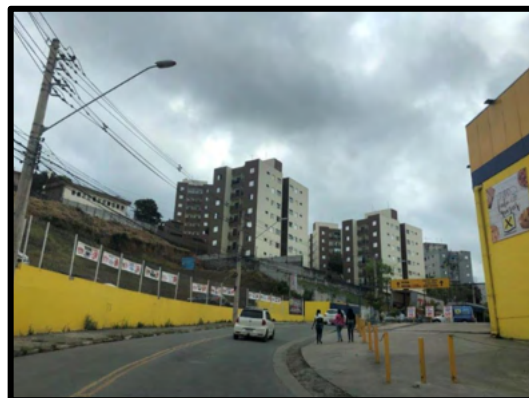
Foto n.º 07 - Detalhe da ocupação local com empreendimentos residenciais próximos à rodovia.
