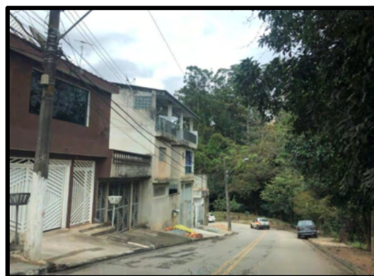
Foto n.º 08 - Detalhe de loteamento residencial, com construções variando de padrão econômico, simples e médio junto à rodovia.
