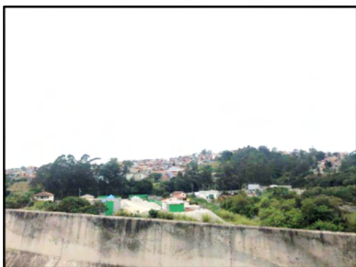
Foto n.º 01 - Vista parcial da rodovia no sentido Av. Raimundo Pereira Magalhães - Rodovia Presidente Dutra e loteamento as margens da obra.
