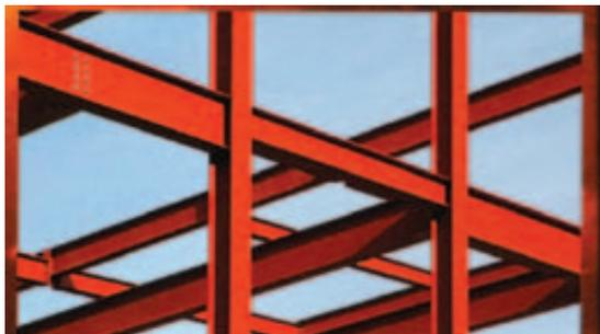
Figura 11: Estrutura pintada com tinta intumescente
