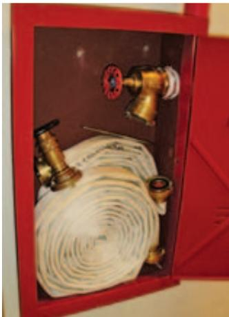
Figura 18: Abrigo de mangueiras, contendo válvula, mangueira de incêndio, esguicho regulável e chave de mangueira
