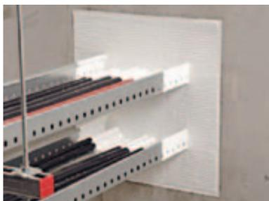
Figura 8: Emprego de espuma expansiva intumescente sobre cabos que transpõem uma parede de compartimentação
