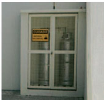
*Figura 23: Exemplo de central predial de GLP, construídas em material incombustível, com acesso restrito e tubulação devidamente sinalizada*
