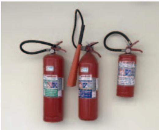
*Figura 15: Da esquerda para a direita, extintores de: água pressurizada, gás carbônico (CO<sub>2</sub>) e pó químico seco (PQS)*
