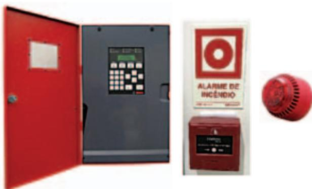
Figura 13: Conjunto de painel central, acionador manual e sonoro/luminoso do sistema de alarme de incêndio
