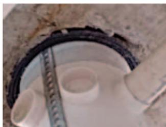
*Figura 7: Detalhe de selo corta-fogo em tubulação no interior de shaft*
