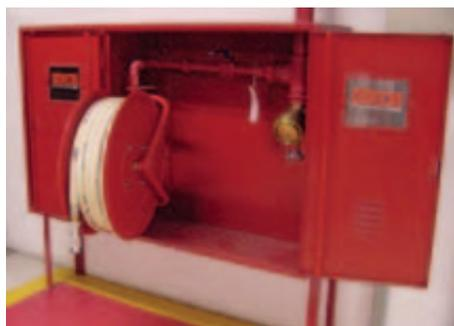
*Figura 20: Carretel com mangotinhos para combate a incêndio em edificações de risco leve*
