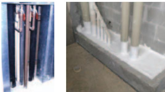
*Figura 6: Exemplos de compartimentação em shafts*
