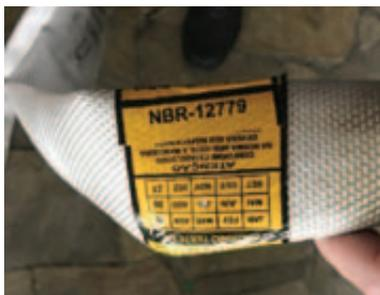
Figura 19: Controle de inspeção das mangueiras de incêndio, conforme ABNT NBR 12779.
